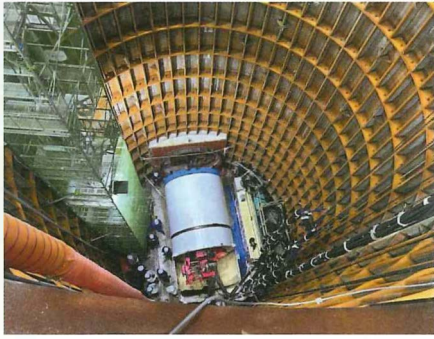
立杭上部から見たシールドマシン
