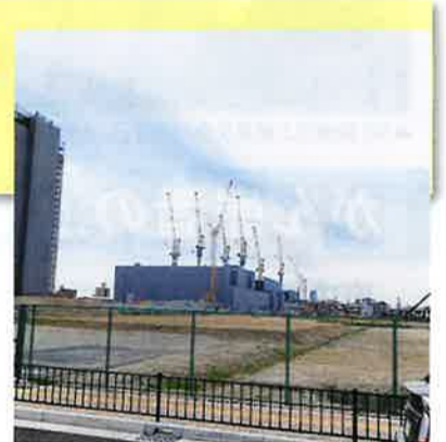
建設が進む北大阪健康医療都市
