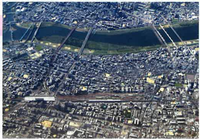
▲上空から見た新大阪駅周辺地域
