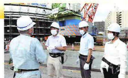
「城北立坑」築造工事現場 視察
