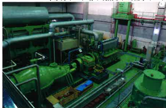
↓氷野ポンプ場の改築された雨水ポンプ
