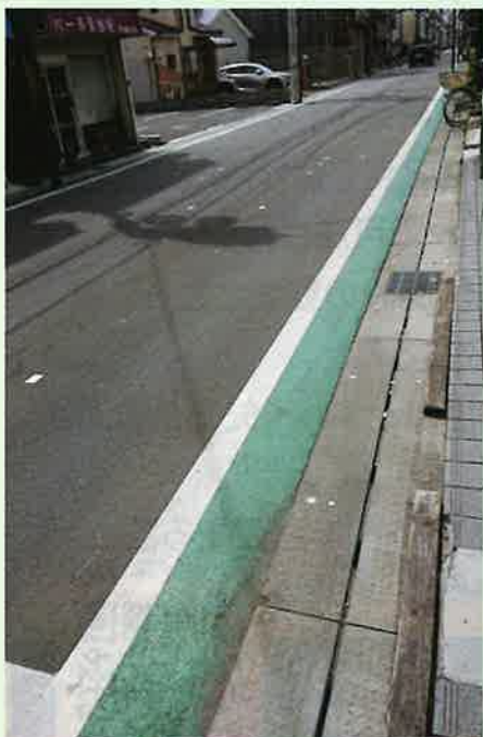
府道高槻・茨木線沿いの昭和ロード商店街からの声で道路側溝整備が完成。
