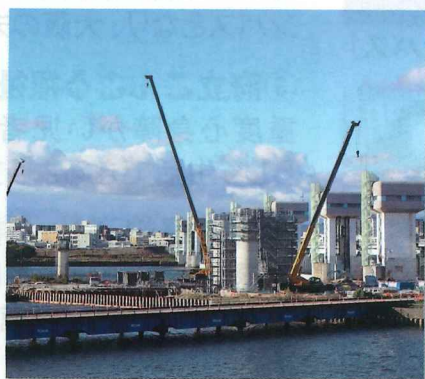
▲ 淀川大堰閘門
