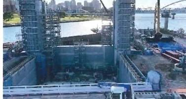
現在、淀川大堰は最大2mの水位差があるため閘門が完成し、いわば舟のエレベーターが実現することで、上下流の航行が可能となります。舟運による河辺のにぎわいと災害時の物資運搬にも活用できる効果あり2025年4月完成を目指し工事中。
